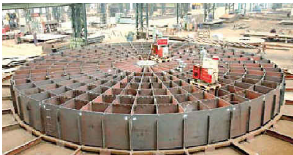
Figure 9 - Fabrication d'un rotor d'un préchauffeur d'air et de gaz
