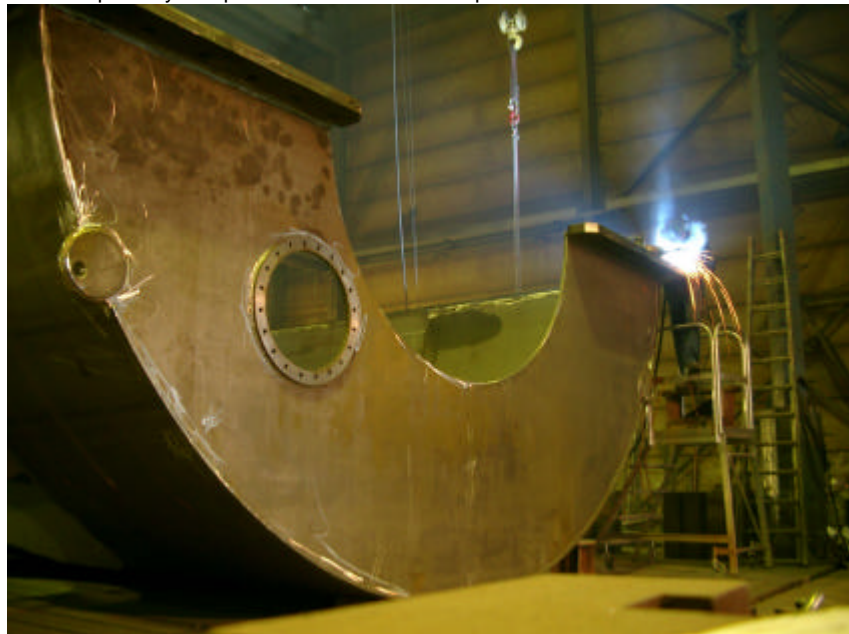
Figure 6 - Soudage d'une enveloppe basse pression pour turbine à vapeur chez Babylon Stahlbau, Viernheim
