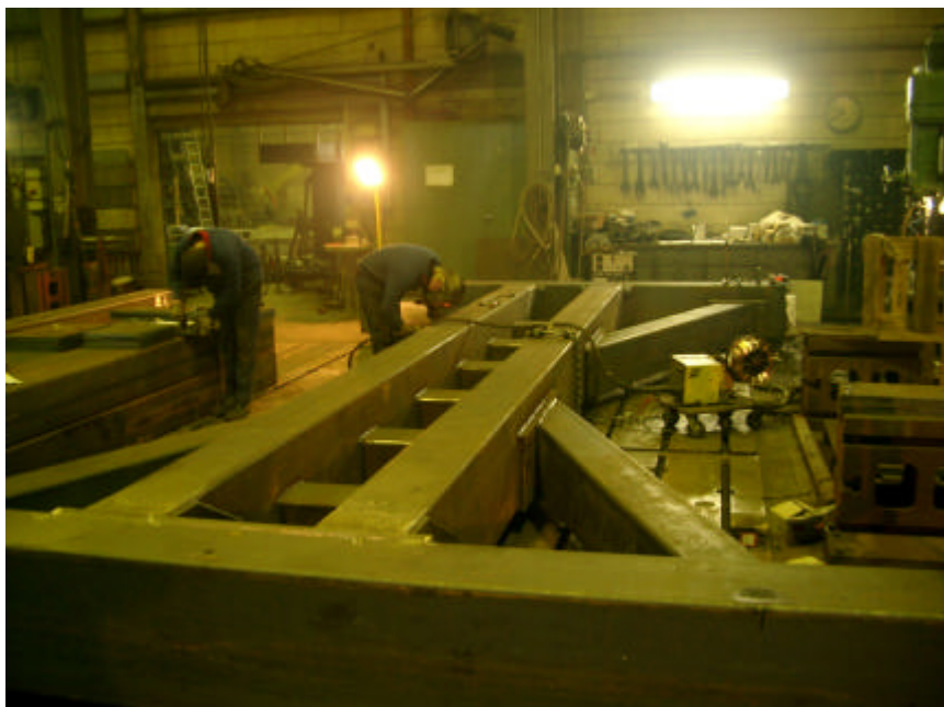
Figure 7 - Soudage d'un châssis chez Babylon Stahlbau
